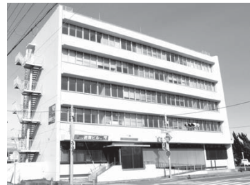
非常用電話が設置された避難ビル(申本1894番地)
