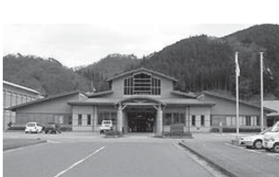
鳥取県日南町役場（木造2階建て）
