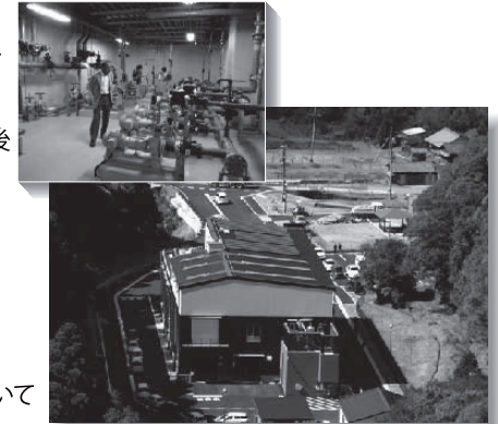
最新の高度処理技術を備えた施設で、処理能力は1日45キロリットル。環境に配慮し、処理後の汚泥を活用します。建設費は16億2750万円・年約7千万円の運営管理委託料
