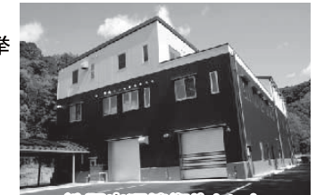
池野山環境衛生センター
